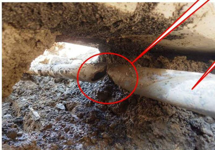
掘削確認したところ、バルブへつながる農水管(塩ビ管)下面に破損箇所発見。
